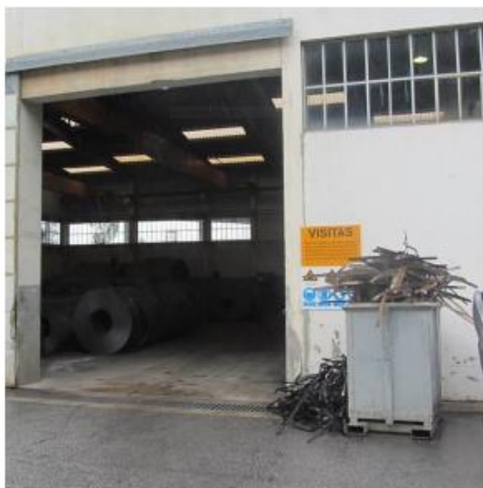
Fotografia 2 – Entrada para a Área produtiva destinada à perfilagem de estruturas de aço.
