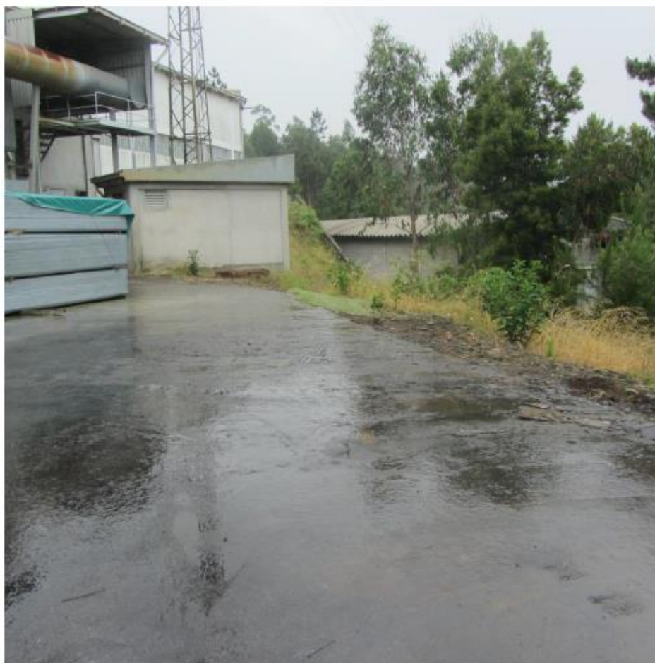
Fotografia 8 – Escorrências superficiais com indícios de óleos e gorduras.
