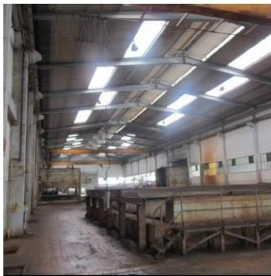
Fotografia 9 – Unidade de Galvanização
