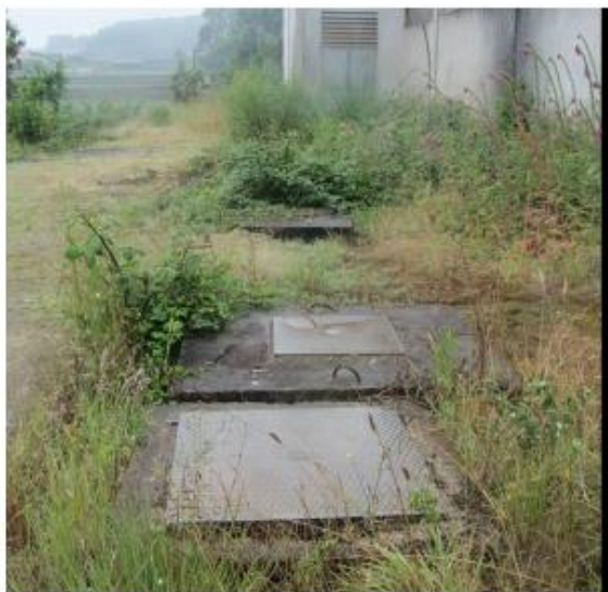
Fotografia 4 – Estrutura enterrada, identificada como a ETAR, e de acordo com a informação prestada, ligada à canalização de condução do efluente resultante, ao rio.
